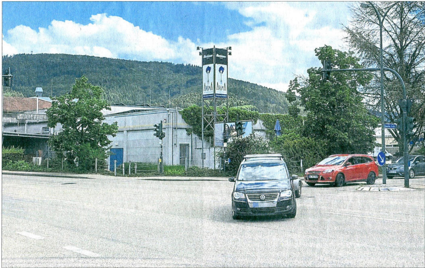
Der erste Abschnitt der Sanierung betrifft die Fahrbahn zwischen Schleifmatt und Diskothek Blockhaus. Im Bereich wird eine Fußgängerampel aufgestellt, da die bestehende außer Betrieb genommen wird.
